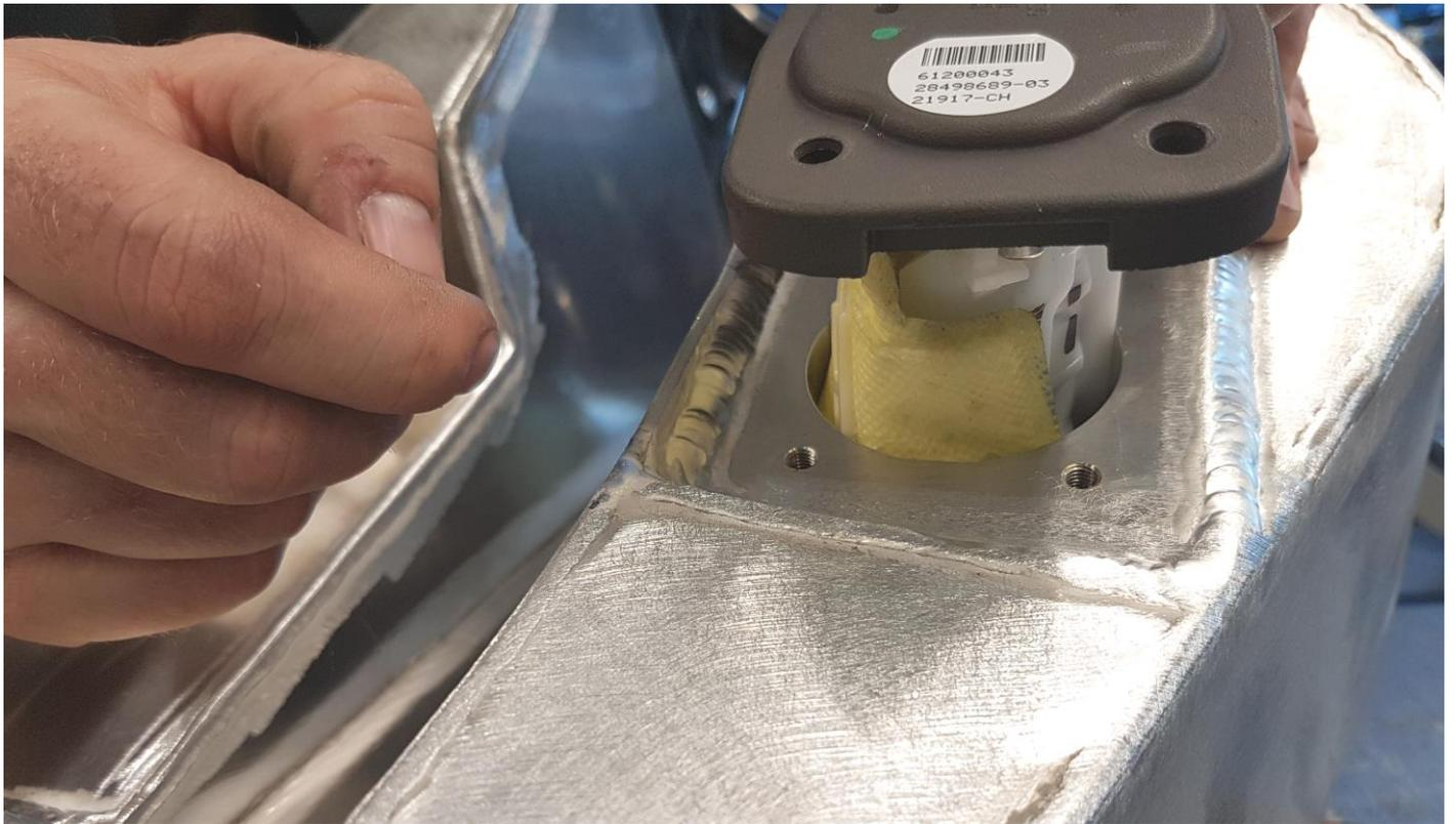
Montieren Sie die Grundplatte mit den beiliegenden M5-Schrauben und Scheiben.
